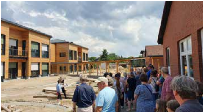
Baustellenbesichtigung Grundschule Techtentin/ Ludwigslust, Planung: B+K Sven Buck+Partner Freischaffende Architekten
